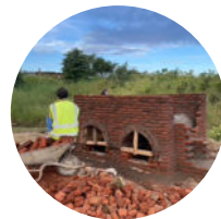
Bau einer Separationstoilette durch Humission's Maurer*innen Team
