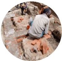
Bau einer Separationstoilette durch Humission's Maurer*innen Team
